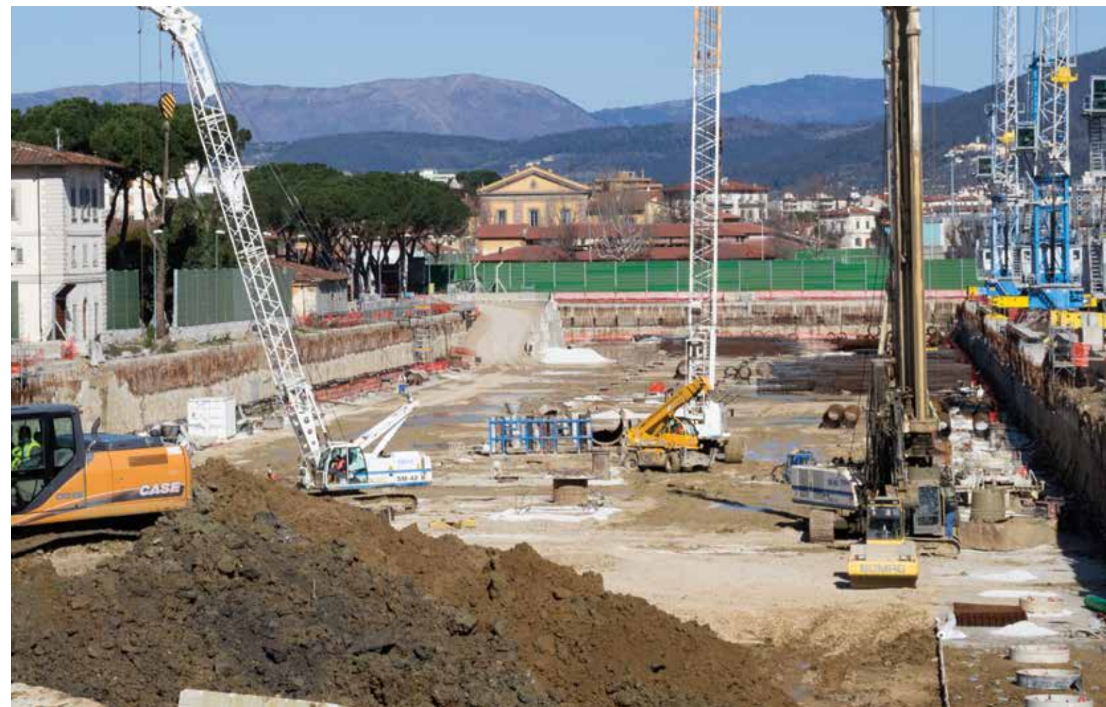
CANTIERE STAZIONE ALTA VELOCITÀ, FIRENZE | HIGH-SPEED TRAIN STATION SITE, FLORENCE, ITALY | CHANTIER DE LA GARE TGV DE FLORENCE, ITALIE
