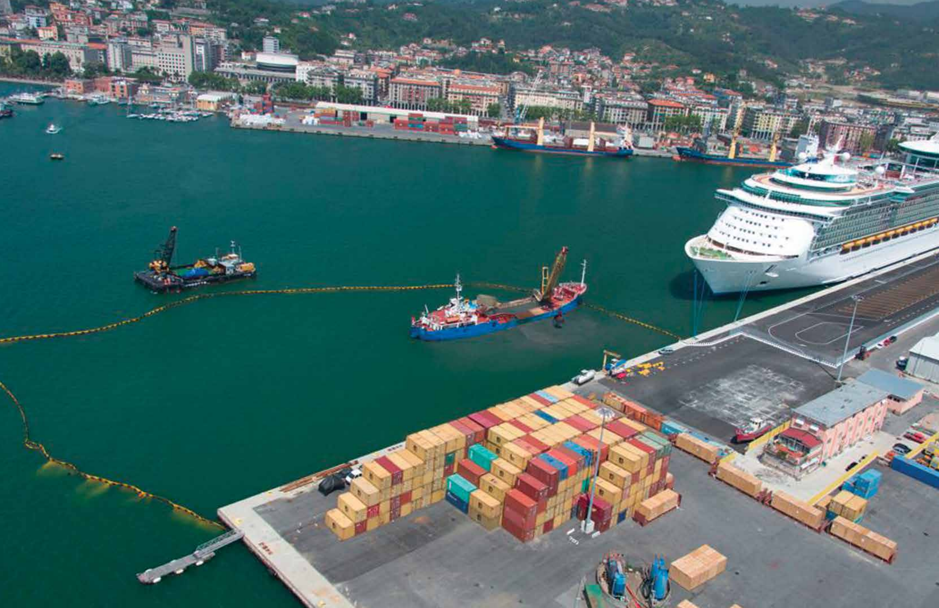
PORTO DI LA SPEZIA - AMPLIAMENTO DEL MOLO GARIBALDI | PORT OF LA SPEZIA, ITALY | PORT DE LA SPEZIA, ITALIE
