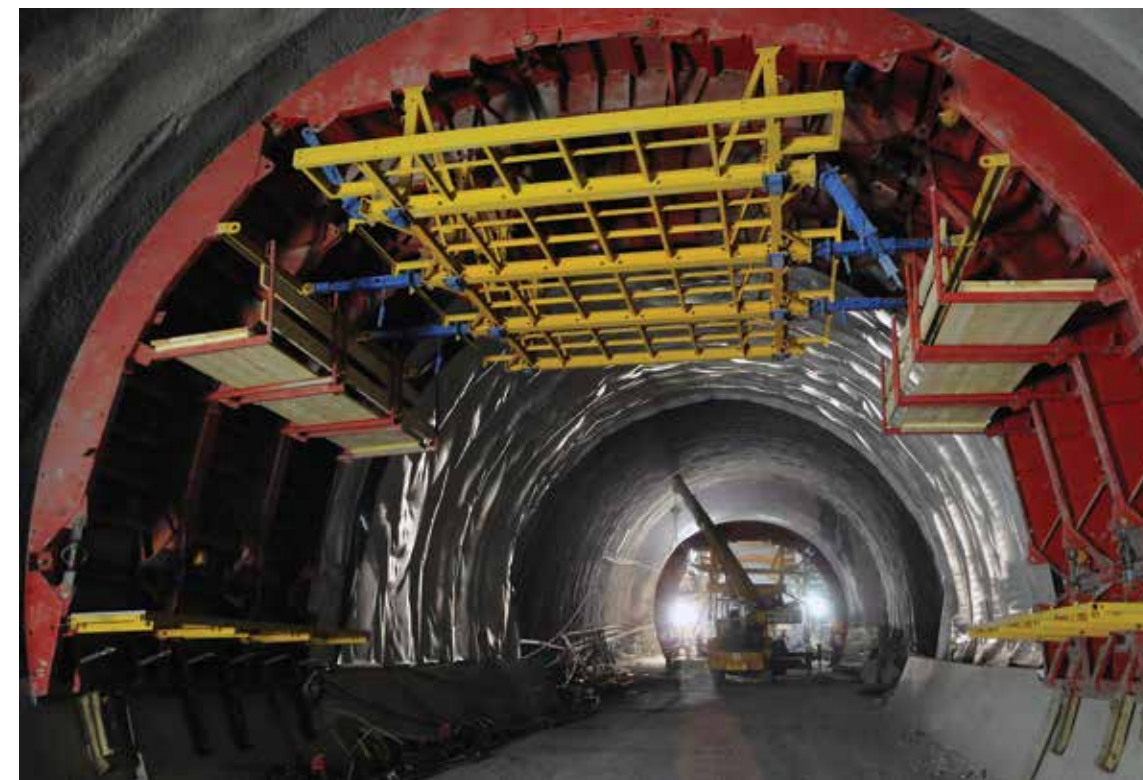
LINEA ALTA VELOCITÀ ALTA CAPACITÀ MILANO-GENOVA | MILAN- GENOA HIGH SPEED RAILWAY LINE, ITALY | LIGNE DE TRAIN À GRANDE VITESSE MILAN- GÈNES, ITALIE
