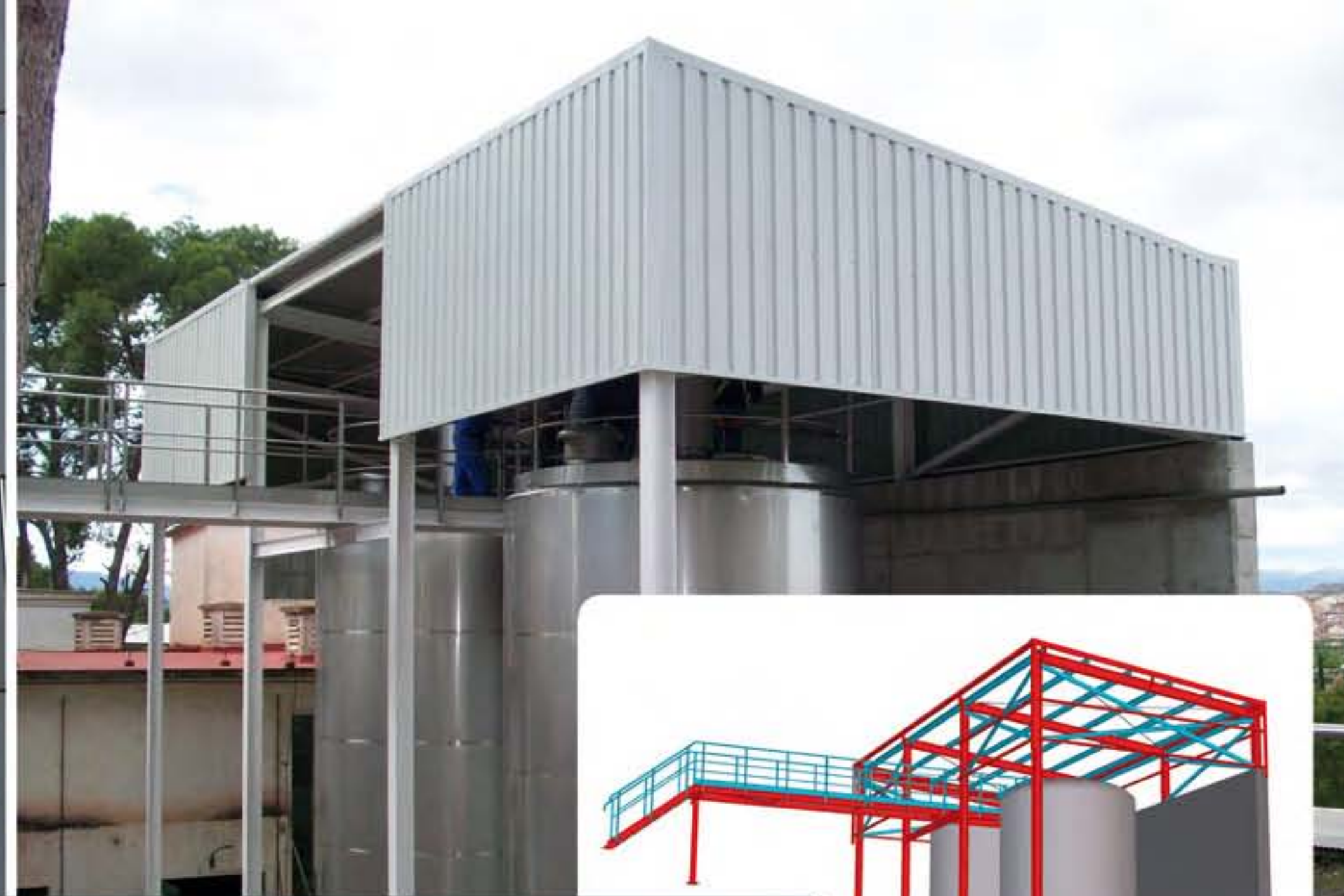
EXPAL | Muro de contención agitadores de masa primitiva EXPAL | Retaining wall agitators of mass explosion hazard
