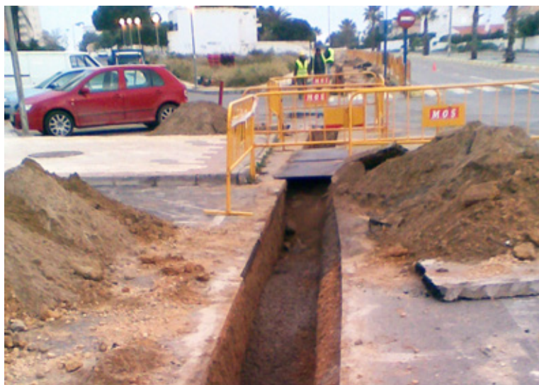
Canalización eléctrica - Cobra
