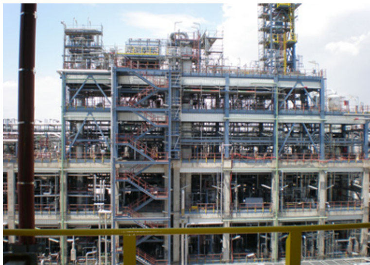
Montaje de 850.000 kg de estructura, tubería y equipos - HPP Polímeros General Electric
