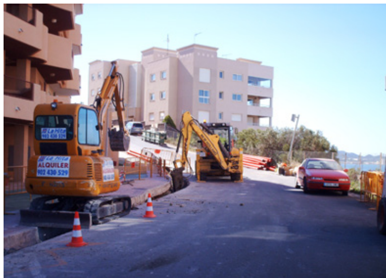
Soterramiento líneas eléctricas - La Manga
