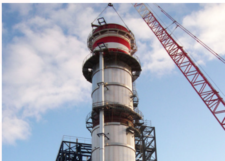
Prearmado, montaje y ajuste de las tres chimeneas de exahustacion - Ciclo combinado - Sagunto
