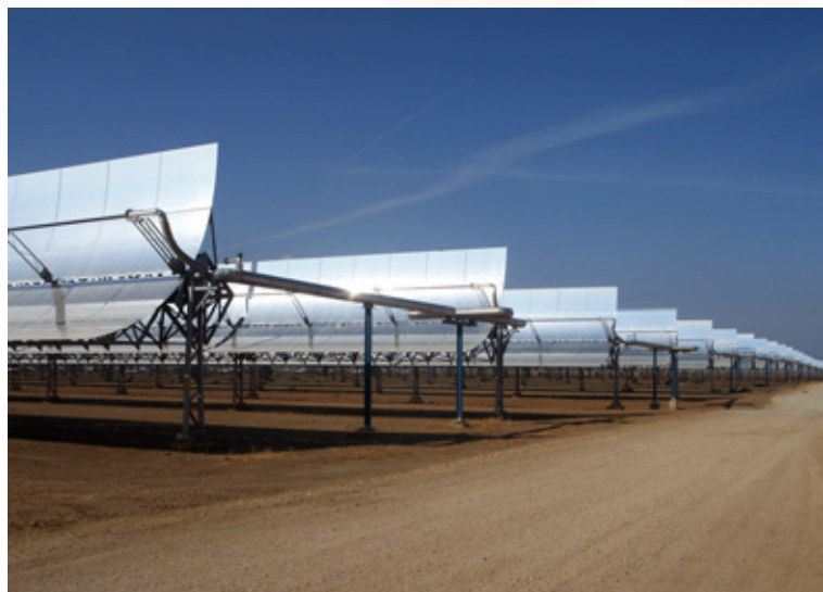
Montaje de equipos y tubería - Planta Termosolar Andasol
