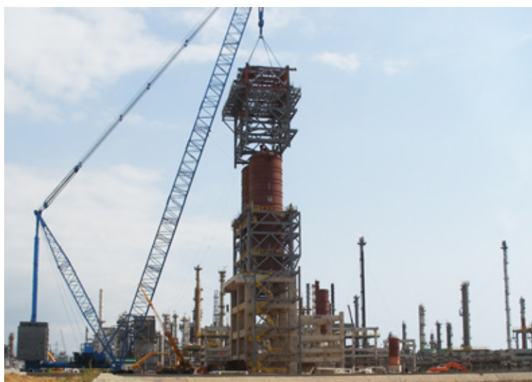
Montaje de estructura de edificio de coque - BP OIL
