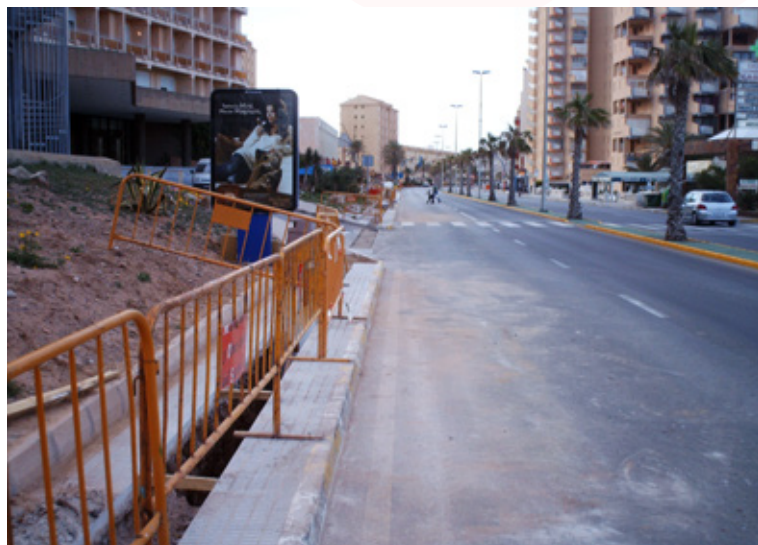
Canalización líneas eléctricas - El Pedrucho - Cobra
